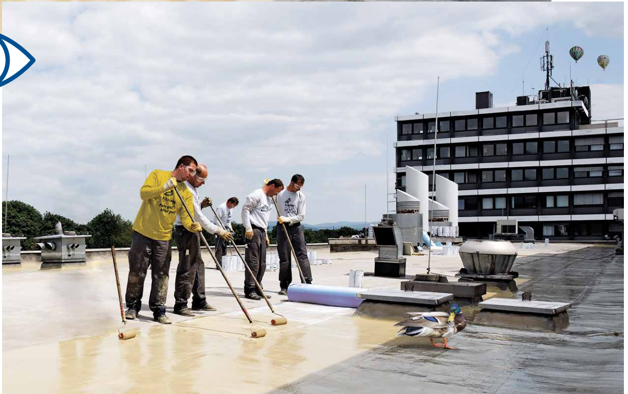
Verarbeitung von KEMPEROL auf dem Dach des HNA Druckzentrums Kassel, 2008.
