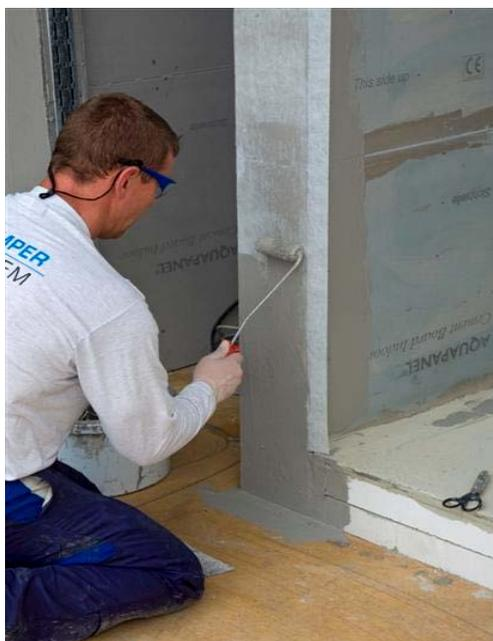
Die Anschlüsse von Zargen und Revisionschächten können mit der flächigen KEMPEROL® 022 Abdichtung eingefasst werden oder im Vorfeld mit dem 15 cm breiten KEMPEROL® 500 Vlies faltenfrei eingefasst werden.
