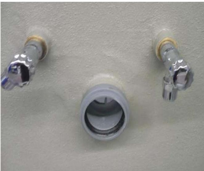
Die Wasseranschlüsse werden dann bei der Durchführung der flächigen Abdichtung nochmals eingefasst, in dem jeweils ein Loch in das Vlies geschnitten und mit ca. dem halben Durchmesser der Wandanschlüsse passgenau über diese gezogen wird.
