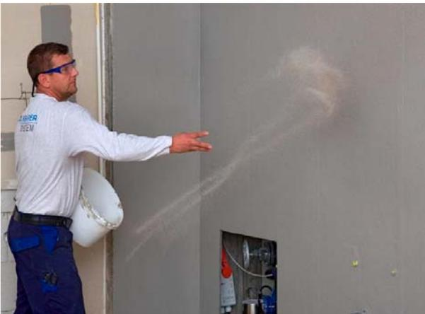
Um eine **Haftbrücke** von der KEMPEROL® 022 Abdichtung zum Fliesenkleber zu gewährleisten, ist in die noch frische Nachlage der KEMPEROL® 022 Abdichtung der KEMPERTEC® NQ 0408 Naturquarz vollflächig einzuwerfen.
