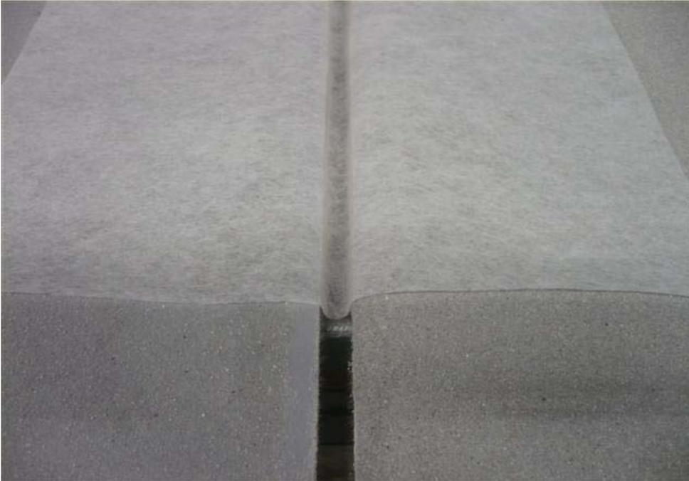
Die Ausbildung einer dynamischen Fuge wird mit einer Schlaufenausbildung ausgeführt. Hier wird zunächst geschlossenzelliges PE als Hinterfüllmaterial in die Fuge gedrückt, um zu vermeiden, dass überschüssiges Material in die Fuge läuft. Anschließend wird das mit Abdichtungsmaterial getränkte KEMPEROL® 500 Vlies mittig über den Fugenspalt gelegt und mit dem Perlonroller angedrückt.
