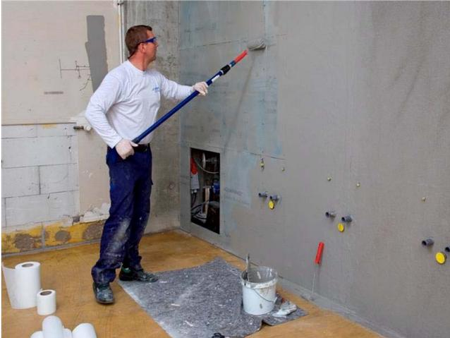
Auf den vorbereiteten Untergrund wird ca. die Hälfte der für einen Quadratmeter benötigten Menge an KEMPEROL® 022 Abdichtung vorgelegt.
