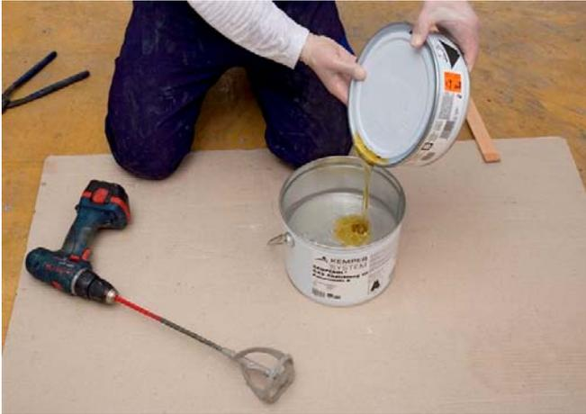
Die Komponente B der KEMPEROL® 022 Abdichtung wird der Komponente A zugesetzt und mit einem langsam laufenden Rührwerk ( Bohrmaschine mit entsprechendem Aufsatz, ca. 300 U/ min möglich ) gut durchgemischt.
