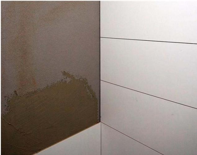
Die KEMPEROL® 022 Abdichtung ist bei einer Temperatur von 23°C nach 16 Stunden begehbar und somit auch in Verbindung mit dem Fliesenkleber KEMPERDUR® MT Fliesenkleber mit Fliesen belegbar.
