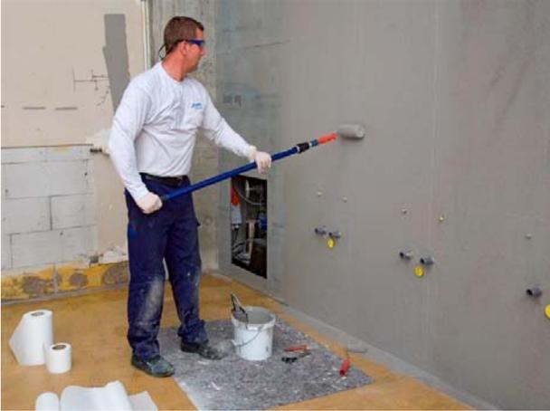
Sofort im Anschluss hieran wird mit ca. der zweiten Hälfte der für einen Quadratmeter benötigten KEMPEROL® 022 Abdichtung bis zur vollständigen Sättigung nachgetränkt.
