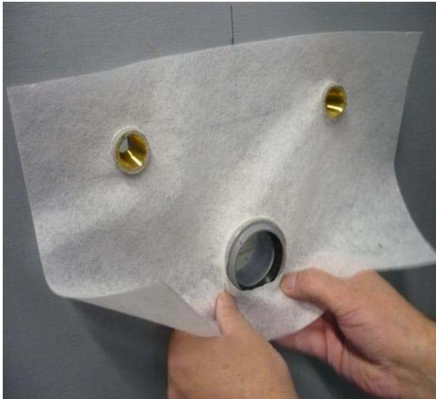
Bei der Abdichtung der Kalt- und Warmwasseranschlüsse mit Hahnverlängerung werden zunächst zwei Vlieszuschnitte angefertigt.
