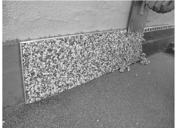
Reste dieser Mischung dürfen **nicht** für den waagerechten Flächenbelag eingesetzt werden!
