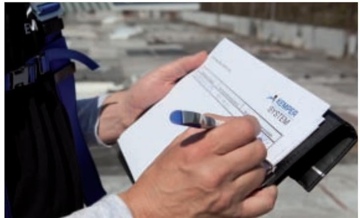
KEMPEROL® FALLSTOP muss mit einem Materialverbrauch von insgesamt 1,6 kg/m<sup>2</sup> aufgebracht werden. Um aufgrund der Wölbung eine einheitliche Schichtstärke erreichen zu können, sind 4 Arbeitsgänge mit jeweils 400 g/m<sup>2</sup> erforderlich.
