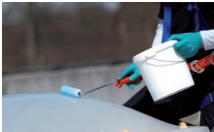
**2** Das abgemessene Material wird entweder oben auf der Lichtkuppel portionsweise ausgegossen, oder direkt aus dem Gebinde heraus verarbeitet. Die Verarbeitung erfolgt mit der KEMPERTEC® Schaumstoffrolle gleichmäßig im Kreuzgang.
