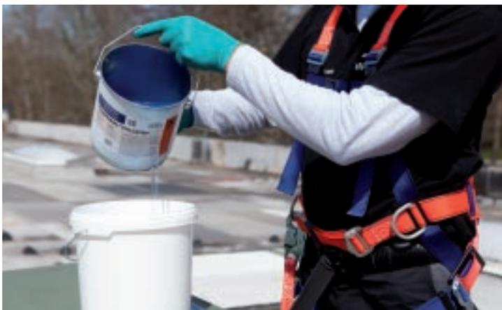
**1** Nach dem Öffnen des Gebindes wird das Material aufgerührt. Danach sollte der Materialbedarf pro Arbeitsgang passgenau für die Lichtkuppel abgemessen werden (**400 g/m<sup>2</sup>/Arbeitsgang**).
