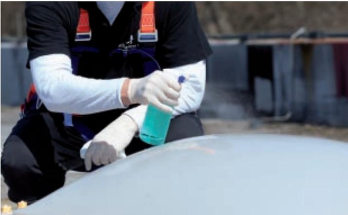
Neue und vorgereinigte Lichtkuppeln müssen gründlich mit einem fusselfreien Tuch und KEMPERTEC® FALLSTOP Cleaner gereinigt werden. Der Reiniger muss mind. 15 Minuten abfließen, bevor mit den Beschichtungsarbeiten begonnen werden kann. Vermeiden Sie Wassereinschlüsse (z. B. an Verschraubungen oder im Dichtungsband) infolge der Reinigungsarbeiten.
