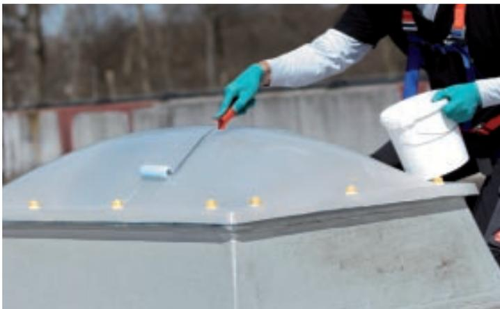
Nach ca. 4 Stunden ist KEMPEROL® FALLSTOP weiterbeschichtbar. Der beschriebene Beschichtungsvorgang muss 3 x wiederholt werden. Hierbei sind die beschriebenen Arbeitsschritte **1** bis **5** einzuhalten.
