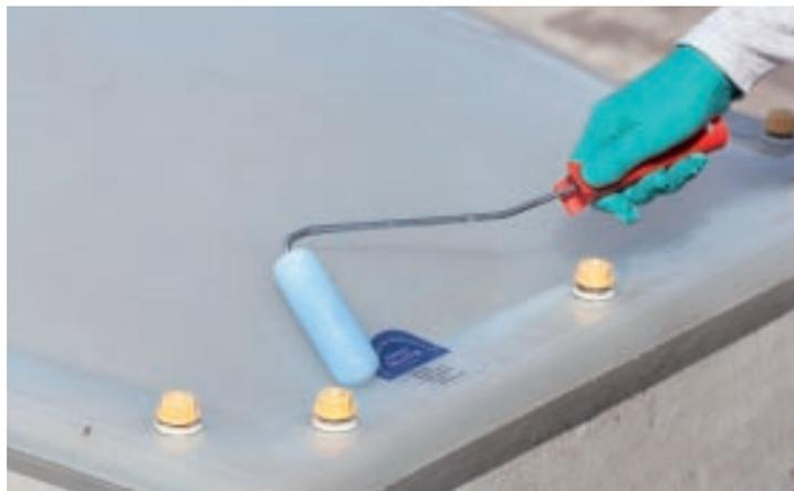
Das mit einer fortlaufenden Nummer versehene KEMPEROL® FALLSTOP Siegel ist mit einem lösemittelbeständigen Stift auszufüllen und auf die ausgehärtete dritte KEMPEROL® FALLSTOP Schicht aufzukleben. Mit dem letzten Beschichtungsgang wird das Siegel ebenfalls mitbeschichtet.
