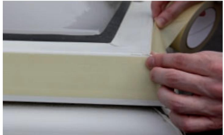
Bei Lichtkuppeln mit Rahmen muss die Oberseite des Rahmens komplett mitbeschichtet werden. Um die Seiten des Rahmens zu schützen, müssen diese sorgfältig abgeklebt werden. Das Klebeband darf erst entfernt werden, wenn das Material so weit angezogen hat, dass es keine „Läufer“ oder „Tropfnasen“ mehr geben kann.
