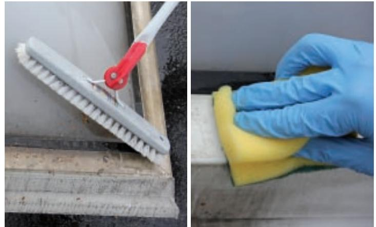
Je nach Verschmutzungsgrad müssen alte und bewitterte Lichtkuppeln zuerst vorsichtig mit einem Schrubber und Wasser vorgereinigt werden. Bei Lichtkuppeln mit verschmutztem Rahmen ist der Einsatz eines Scheuerschwamms sinnvoll.
