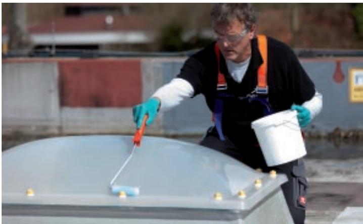
**3** Das Material muss gleichmäßig horizontal und vertikal aufgerollt werden. Hierbei sind Blasen und Fehlstellen unbedingt zu vermeiden.
