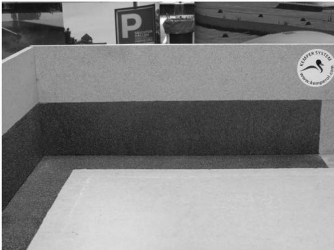
Vor Abdichtungsarbeiten mit KEMPEROL Abdichtung muss erneut abgeklebt werden. Hierbei ist ein neues Gewebeband ca. 1-2 mm oberhalb der KEMPERTEC Grundierung anzubringen.
