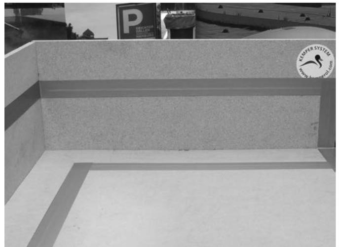
Beim Abkleben das Gewebeband andrücken und abschließend mit der Hand glatt streichen, um unterlaufendes Material zu vermeiden.
